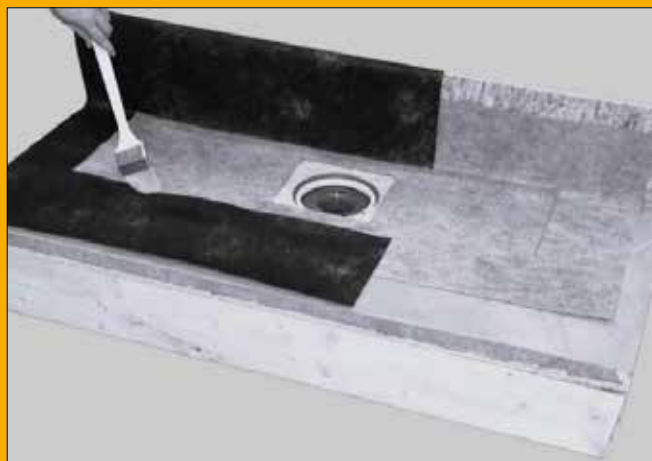
10. Montera SikaCeram® Sealing Membrane W och överlappa manschetten med 50 mm. försegla skarv med SikaCeram® Sealing Fix , Sikalastic®-220 W alt. SikaCeram®-920 Foil Bond (2 strykningar).
