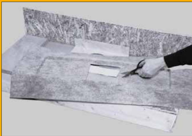
5. Klipp ut hål för att frilägga brunnen i den stora manschetten. Minimum 50 mm överlapp.
