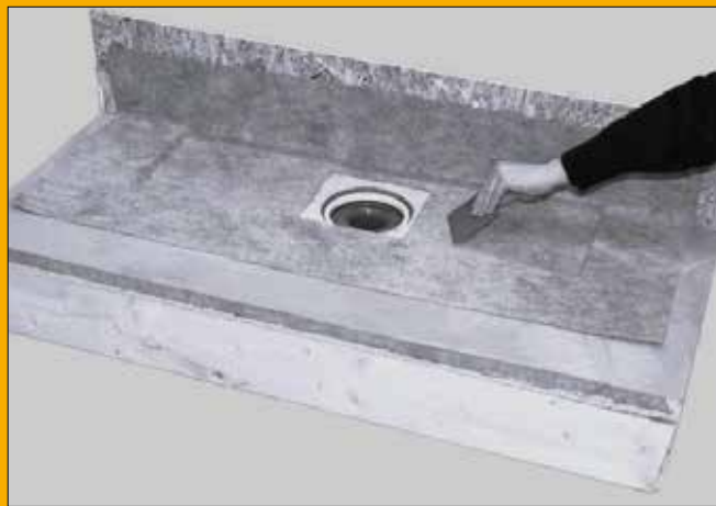
6. Applicera medföljande tätskiktetsmanschetten och tryck noga fast den. Minst 50 mm överlapp!
