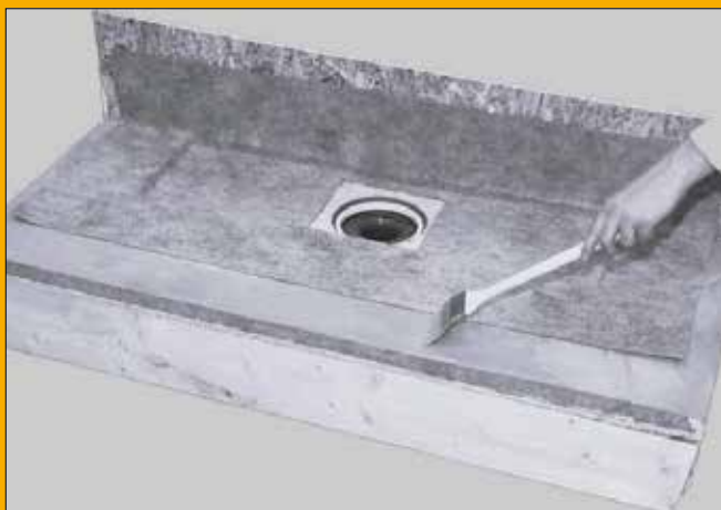
9. Limma mot absorberande underlag (golv/vägg/betong) - SikaCeram® Sealing Fix alt. Sikalastic®-220 W med roller och pensel.
