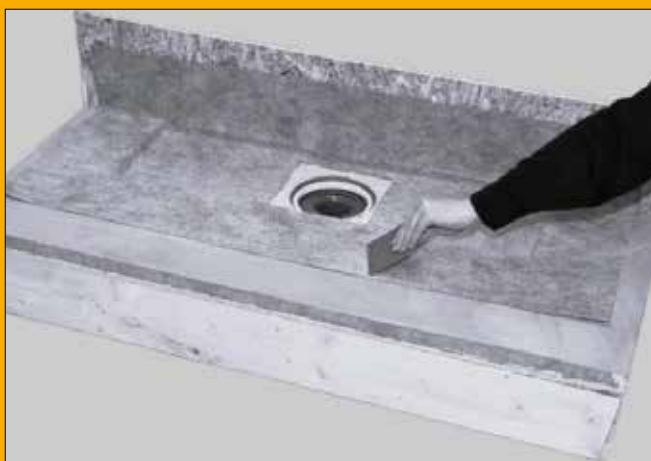
7. Applicera den medföljande tätskiktets manschetten och tryck noga fast den. Säkerställ så att inga blåsor eller veck uppstår.
